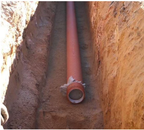
Figura 6 Obra de expansão da rede de água
