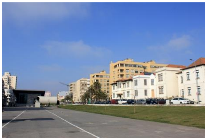
Figura 4 - Plataforma à Superfície do Canal Ferroviário
